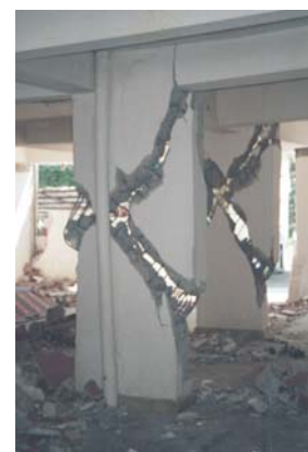
شکل ۱- جذب انرژی در هنگام زلزله با تغییر شکل های دائمی و غیر قابل بازگشت در عناصر سازه ای همراه است.
