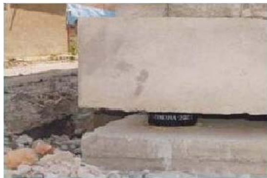
شکل ۹- استفاده از سیستم های جداگر لرزه ای در مقاوم سازی ساختمان های موجود. سمت راست، ساختمان بتن آرمه و سمت چپ، ساختمان تاریخی
