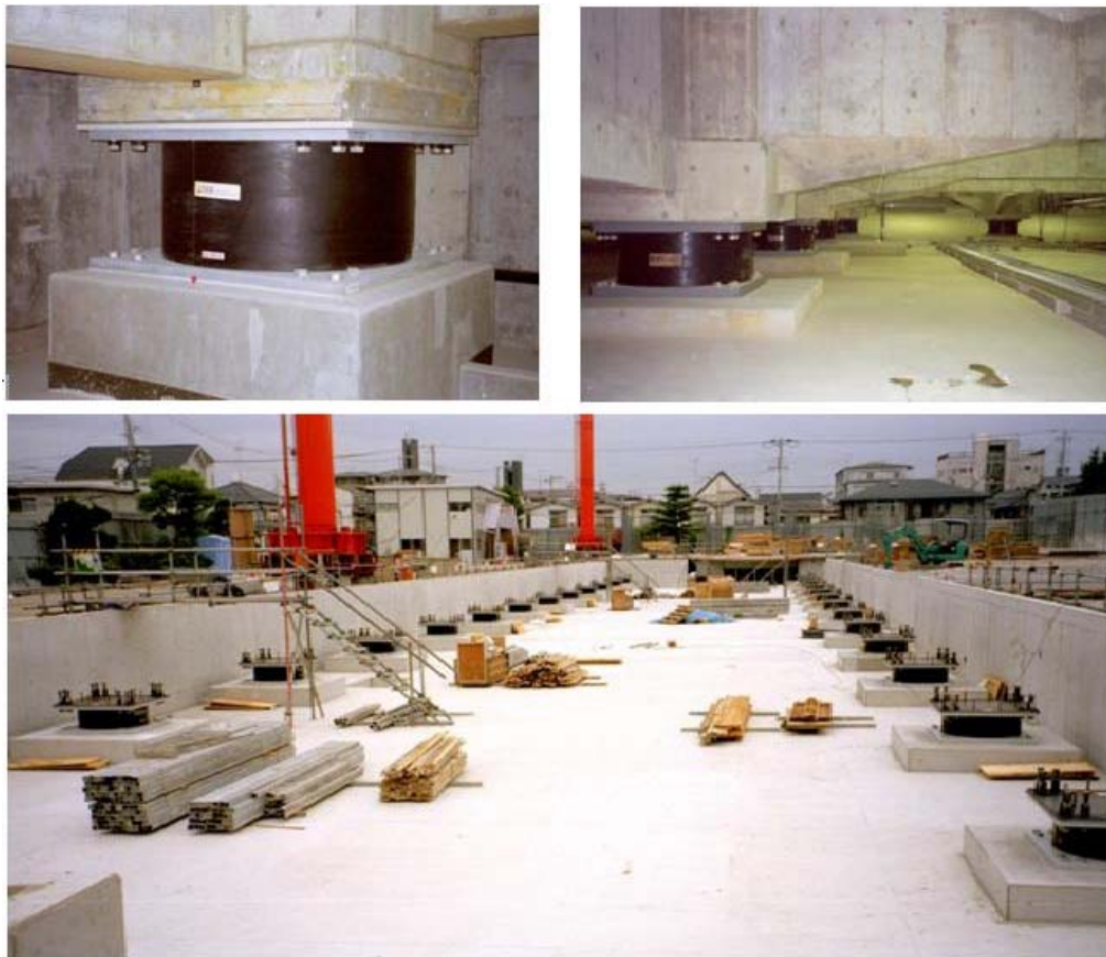
شکل ۵- سیستم جداگر لرزه ای
