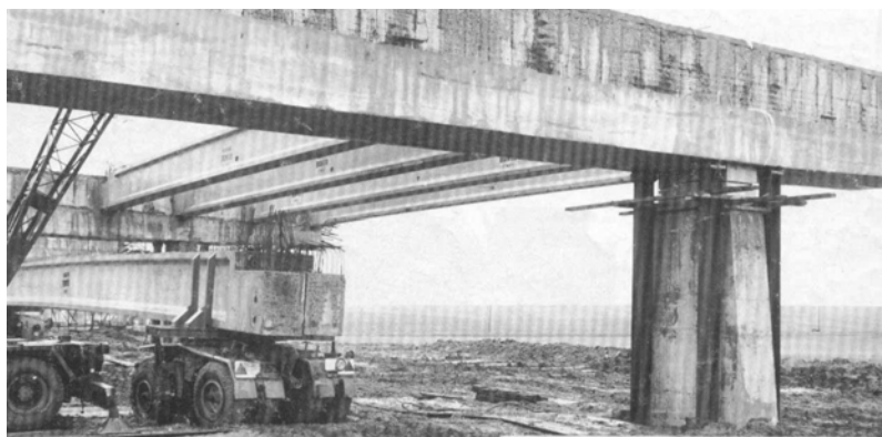
اجرای پل بزرگراه با استفاده از روفیکس در آلمان
